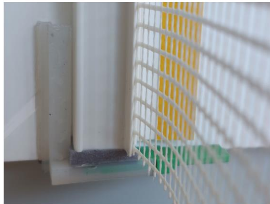
sl. 3: Gip-traka leži na traci od penastog materijala StoProfile Drainage
