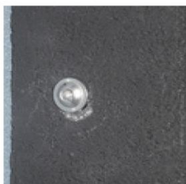
slika 3: učvršćivanje StoElement Fauna FM-F 20
