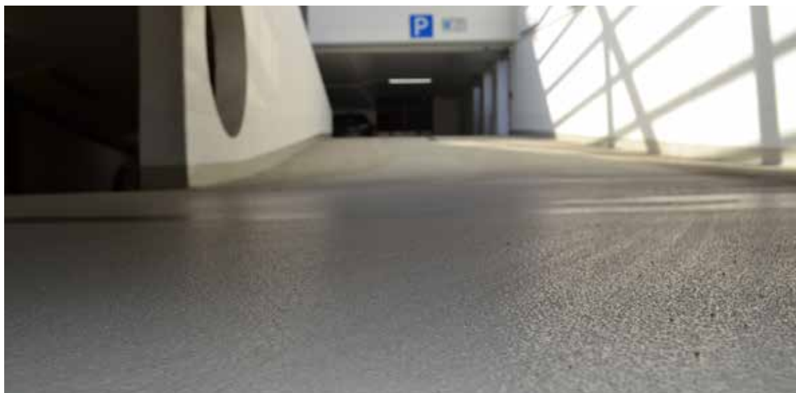
Višespratno parkiralište, Kirchheimbolanden, DE StoCretec kompetencije: sistemi za zaštitu površine Slika: StoCretec
